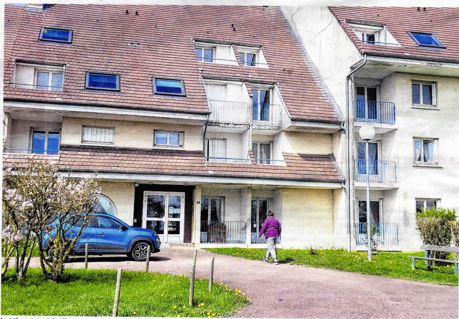
La résidence autonomie Les Marronniers, à Formerie, ne compte plus que neuf résidents sur 50 logements.
