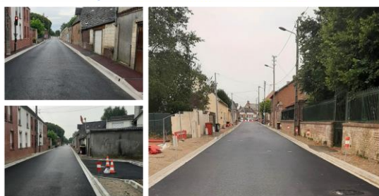
Requalification de la rue de la CHAPELLE
