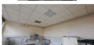
Remplacement des appareillages par du led
