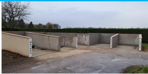
Agrégats pour stockage de matériaux
