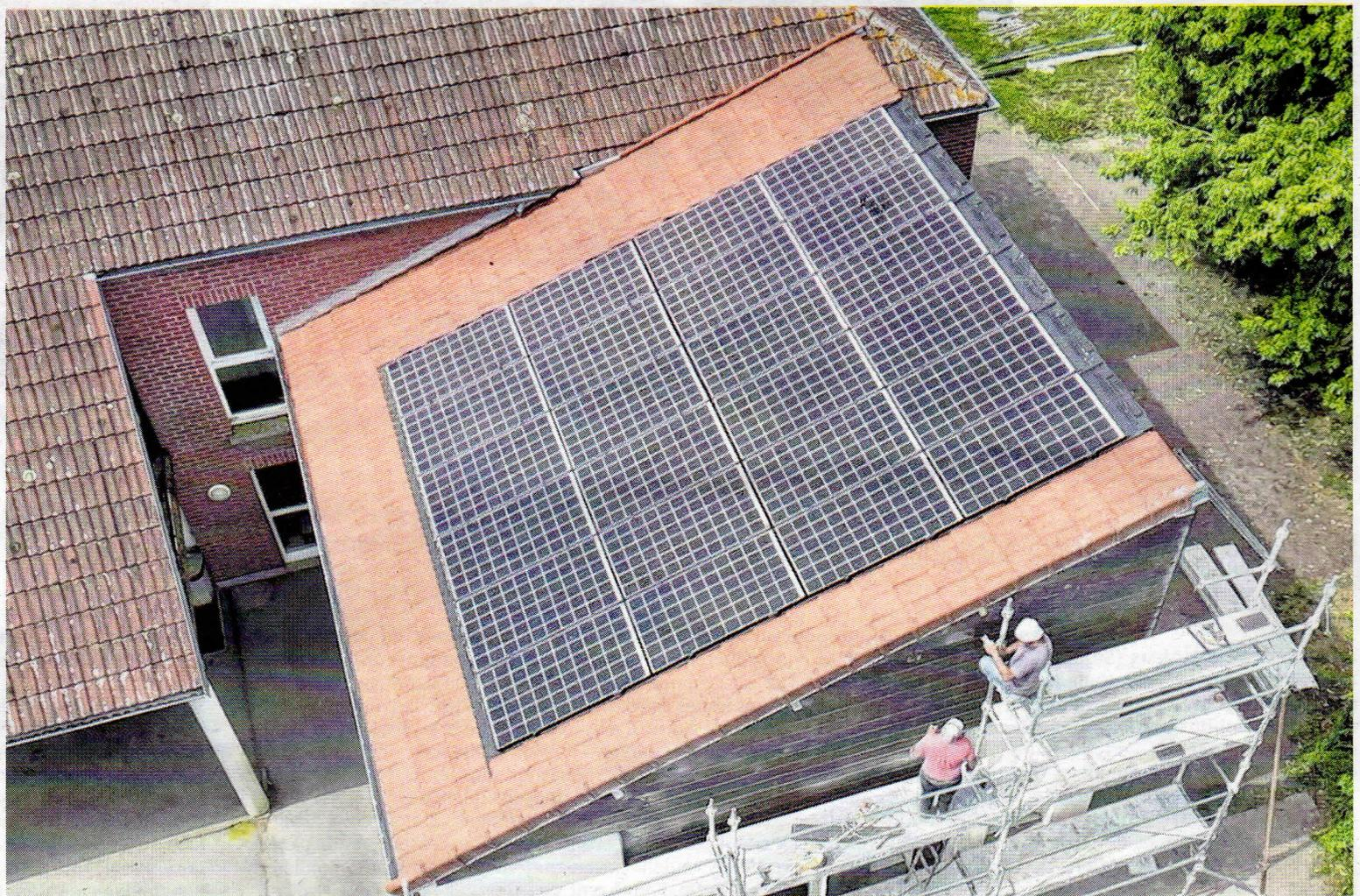
L'ultime partie de chantier de rénovation de la toiture de l'école a permis, en août, la pose de panneaux solaires sur une surface de près de 120 m<sup>2</sup>. « Il faut montrer l'exemple », estime le maire.
