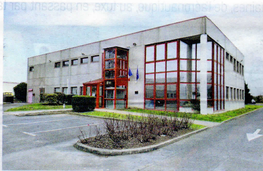
Le siège de la Thelloise a mal vieilli, avec plusieurs problèmes d'isolation et il manque désormais d'espace pour répondre aux besoins administratifs.
