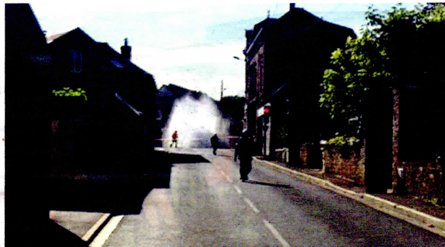
Les pompiers ont projeté de l'eau sur la fuite de gaz pour en éviter l'embrassement.
