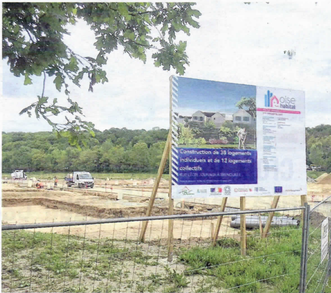
Le site en construction où sera implanté le nouveau lotissement financé avec l'aide de la Banque européenne d'investissement (BEI).
